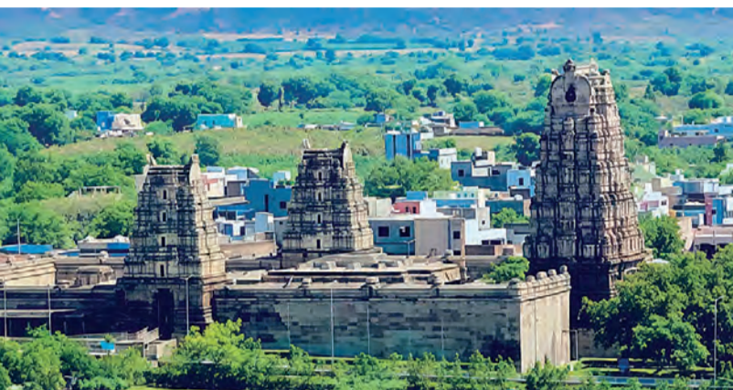
ఓంటిమిట్ట కోడండ రామాలయం
